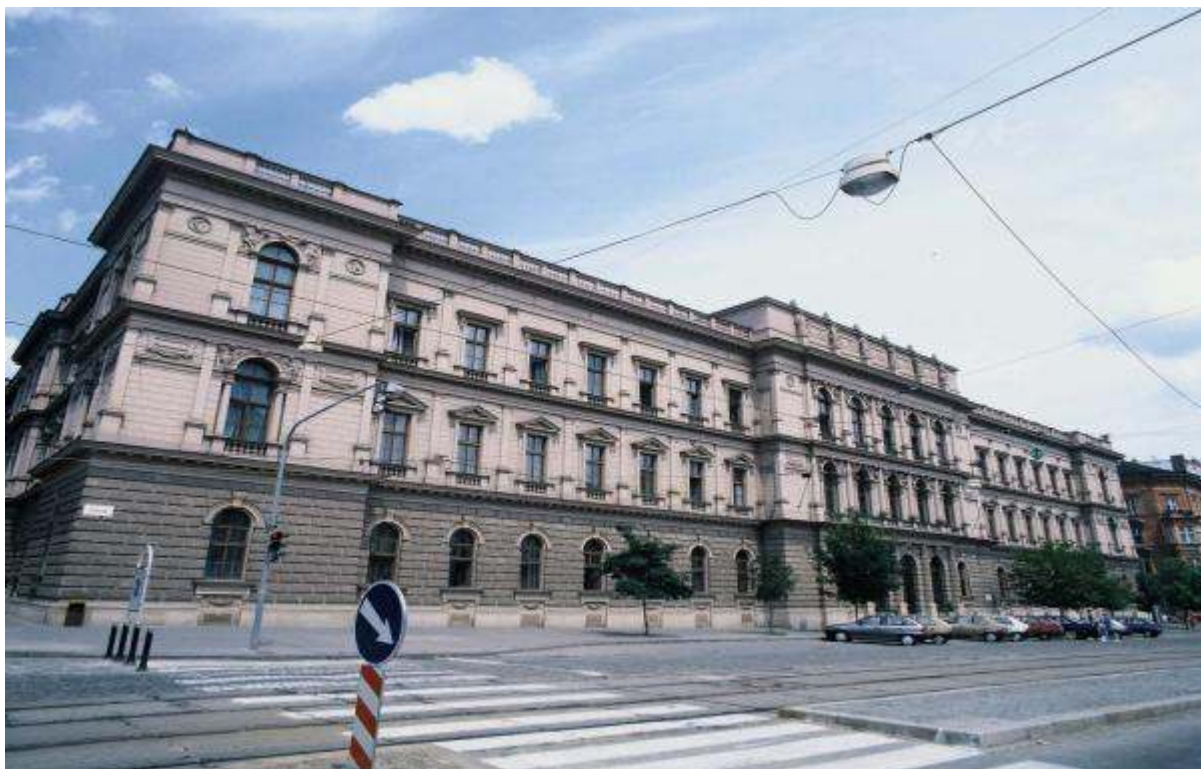
Budova, ve které sídlí Úřad pro ochranu hospodářské soutěže, se nachází v Joštově ulici v Brně
